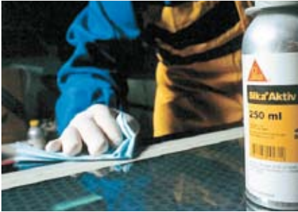
Fig. 128 Applying Sika® Aktivator
